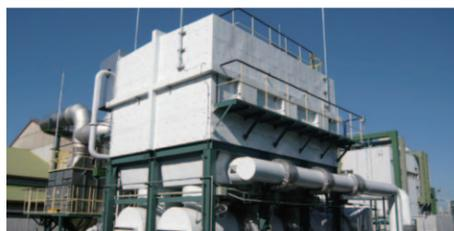
合成ゴム乾燥排気の燃焼処理設備(千葉工場)
