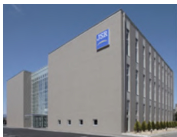
四日市地区研修センター
