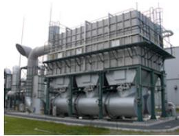
合成ゴム乾燥排気の燃焼処理設備
