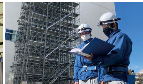
現場での設備確認
