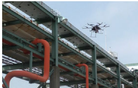
ドローンによる飛行点検
