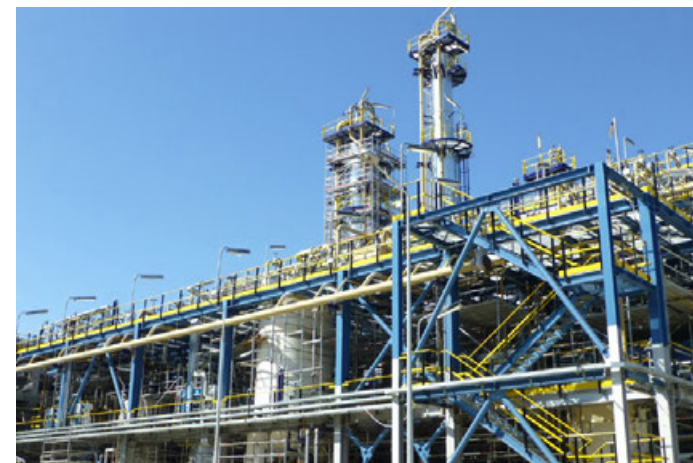
SSBRハンガリー工場(2019年4月完工)
