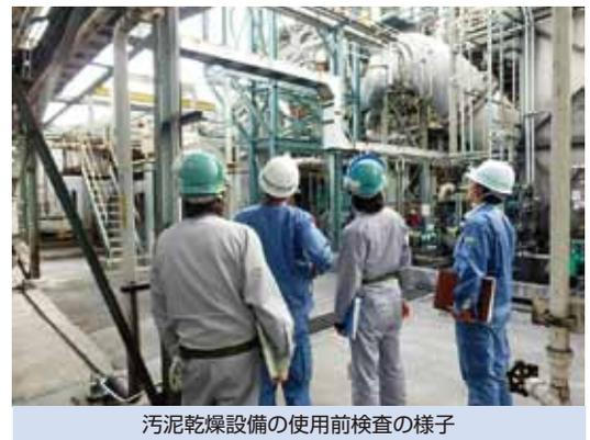
汚泥乾燥設備の使用前検査の様子
