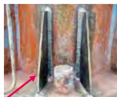
タンク足の補強
