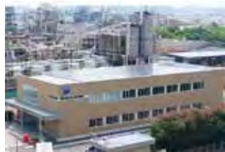
北門厚生棟の太陽光発電
