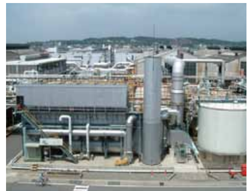
蓄熱燃焼設備の全景
