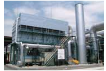
溶液重合ゴムプラントに設置された蓄熱燃焼設備
