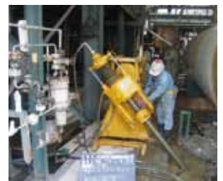
地盤強化工事
