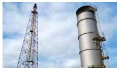
※エレベーターフレア- (写真左) とランドフレア- (写真右) の2基が設置されており、通常はランドフレア-で燃焼し、緊急時はエレベーターフレア-で燃焼させるシステムになっています。ランドフレア-は筒の中で燃焼を行うため、騒音や光、熱等をあまり外に出さずに処理できます。
