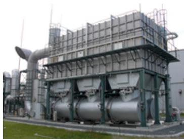
合成ゴム乾燥排気の燃焼処理設備（鹿島工場）
