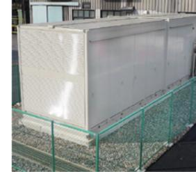
サーバールームや製造設備などで使われる瞬低・短時間停電の補償装置では、瞬時電圧低下や停電が検出されると、リチウムイオンキャパシタに蓄えた電気で数秒~数分のバックアップを行い、非常用発電装置などが作動するまでを補償します。鉛などの重金属を使っていないため、環境負荷が少なく長寿命というメリットがあります。
