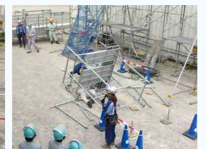
足場倒壊教育
