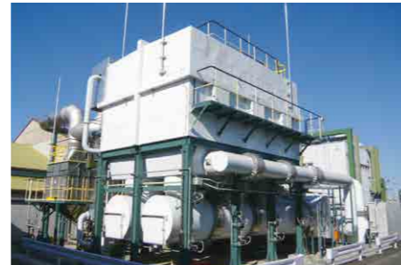
蓄熱燃焼処理設備 (RTO)
