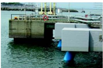
桟橋(バース)の耐震補強工事
