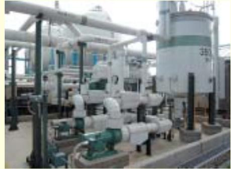
臭化リチウム吸収式冷凍機
