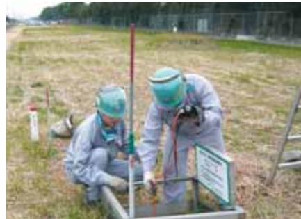
場外導管ガス漏洩の検知
