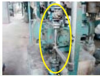
チューブ→鋼管配管に変更
