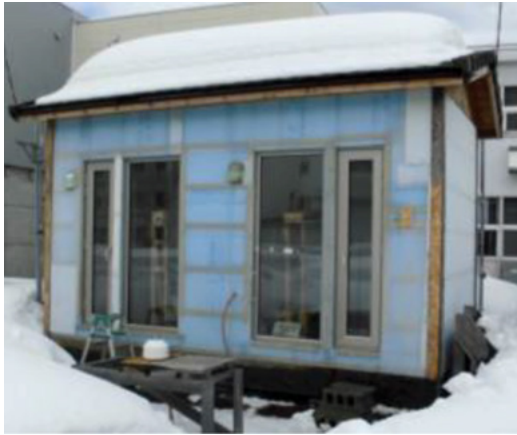
図6 蓄熱建材実証棟
