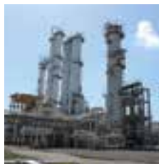
ブタジエンプラント
