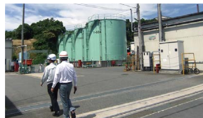
現地確認の様子
