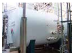
遮熱塗料用材料の提供 (工場のタンクに塗って効果を実証しています。)
