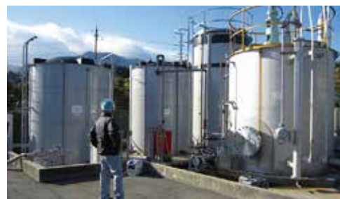
現地確認の様子(エス・エヌ・ケー・テクノ(株))
