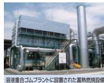
溶液重合ゴムプラントに設置された蓄熱燃焼設備
