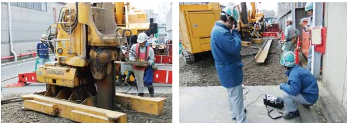
工事中の環境(騒音・振動)確認測定
