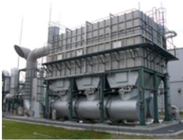
合成ゴム乾燥排気の燃焼設備（鹿島工場）
