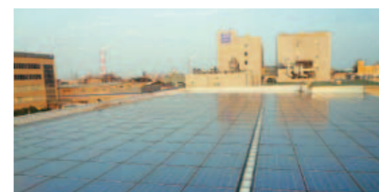
新厚生棟に設置された太陽光発電システム
