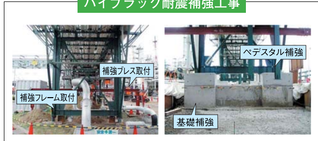
パイプラック耐震補強工事
