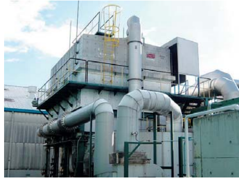
RTO（蓄熱燃焼処理設備）
