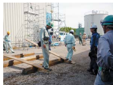
未固定足場板天秤体感
